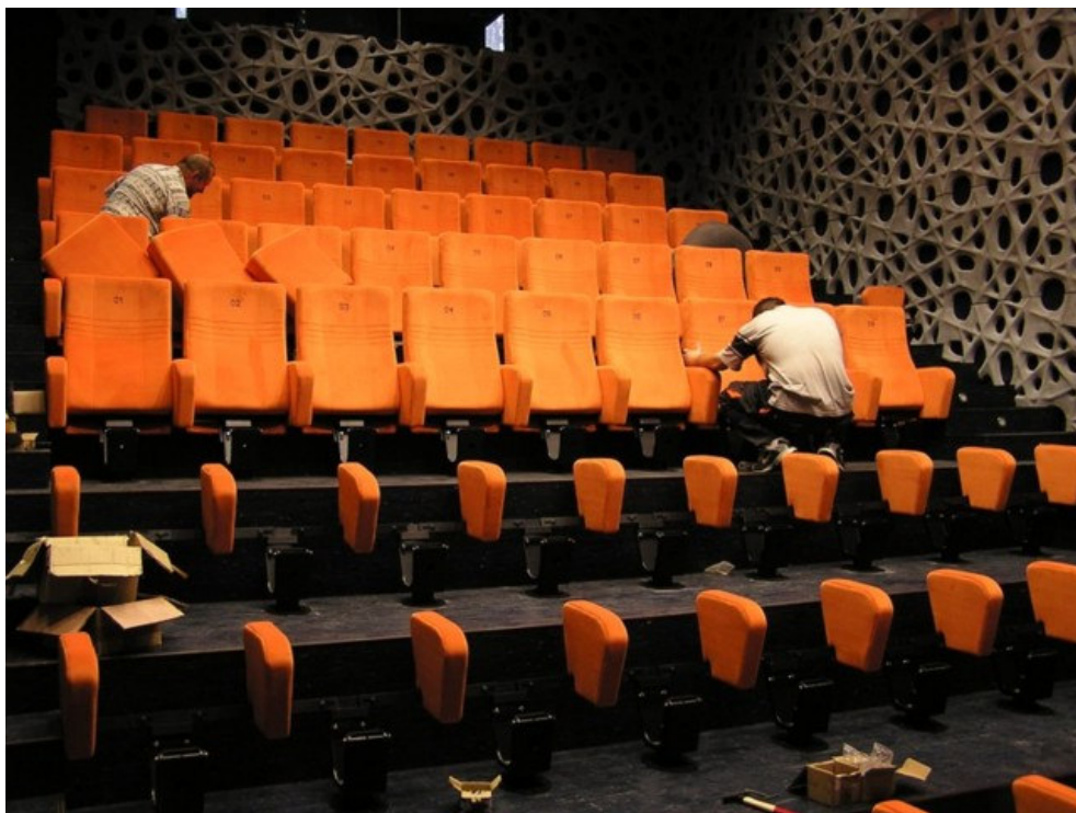
Rekonstrukce kinosálu finišuje
