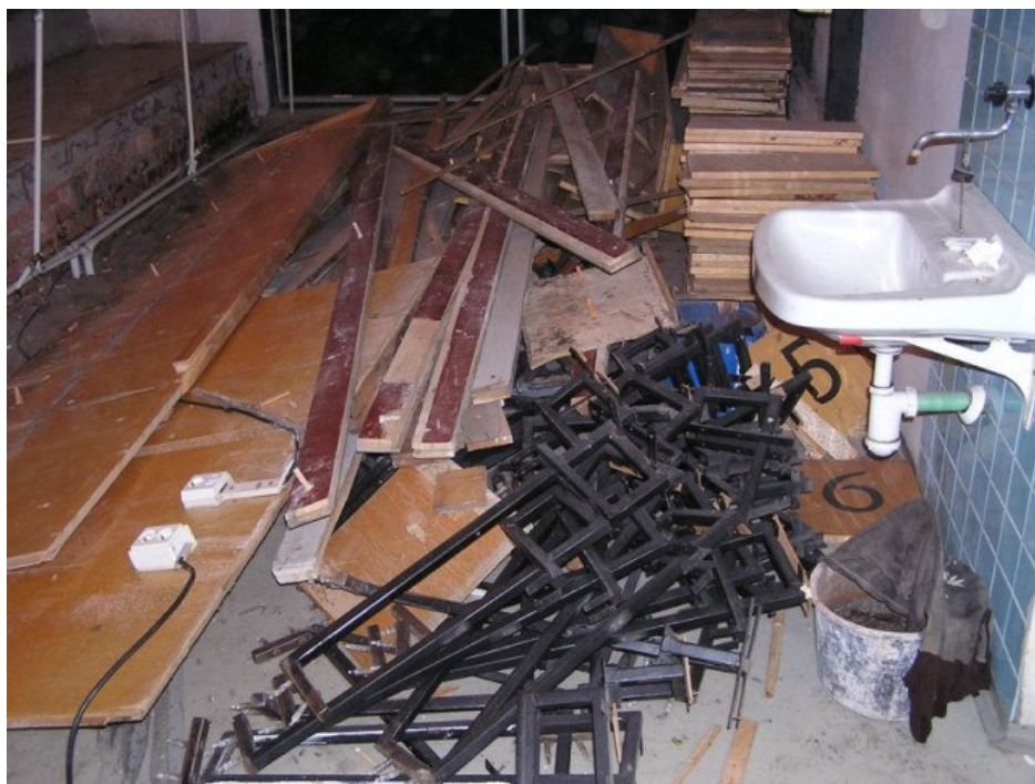
Zahájení rekonstrukce kinosálu
