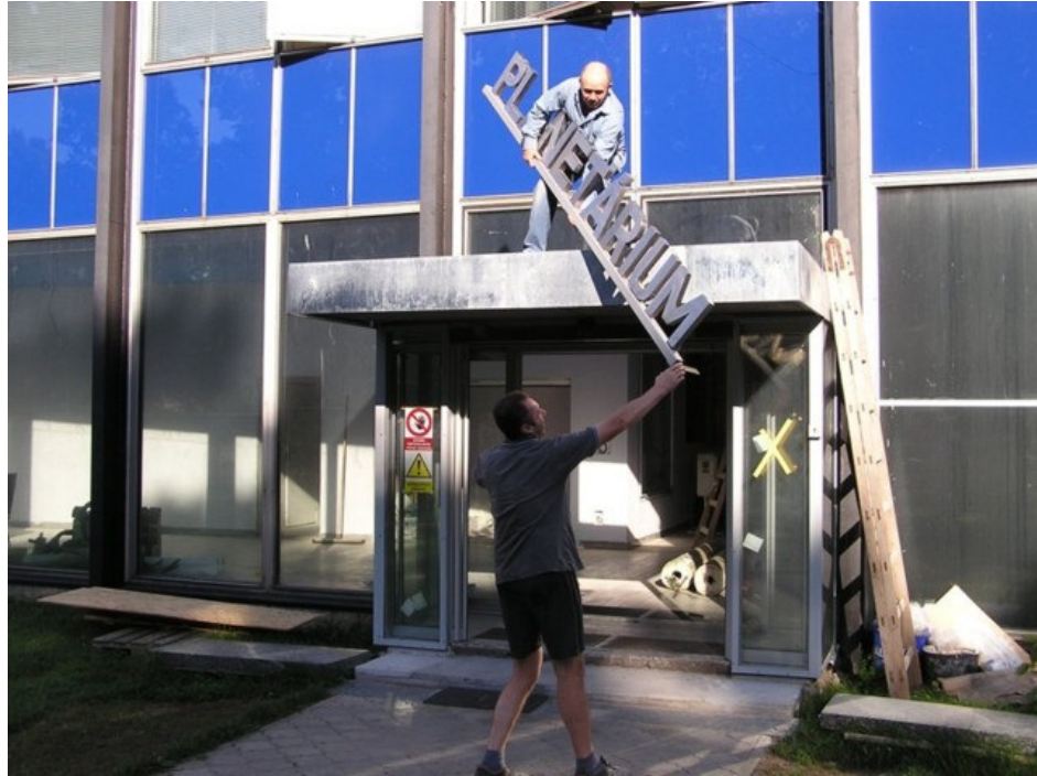
Rekonstrukce vstupu do budovy
