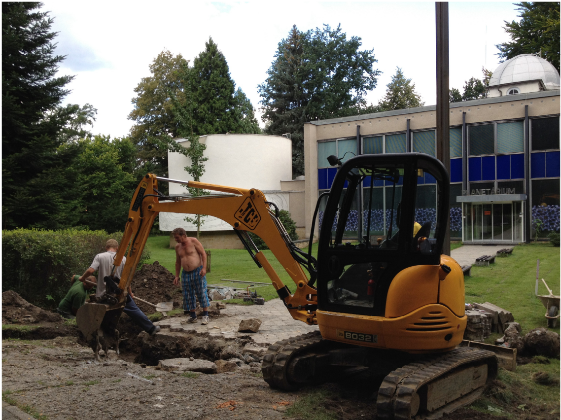
Budování vstupu a části exteriérové expozice na zahradě HaP
